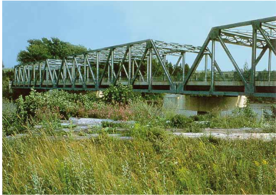
Puente Parrot totalmente galvanizado en Quebec, Canadá
